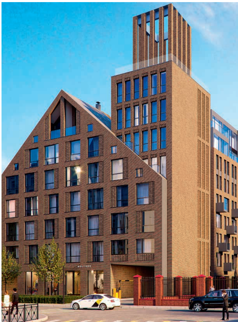
Яркий пример новой краснокирпичной архитектуры Петербурга — ЖК «Мануфактура» от «Студии 44» Никиты Явейна, 2024 г.
