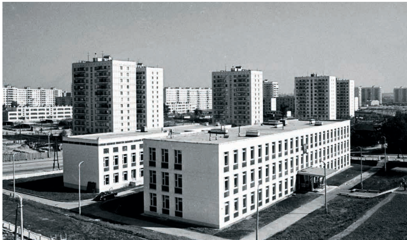
Н-образная модель середины 1960-х, называемая в народе «самолетик». В таких типовых школах воспитывалось полстраны
