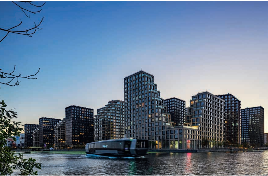
Речной транспорт возвращает людям реку как элемент городской жизни. Маршруты вдоль набережных перестают быть предметом рекреации, становясь частью повседневной логистики
