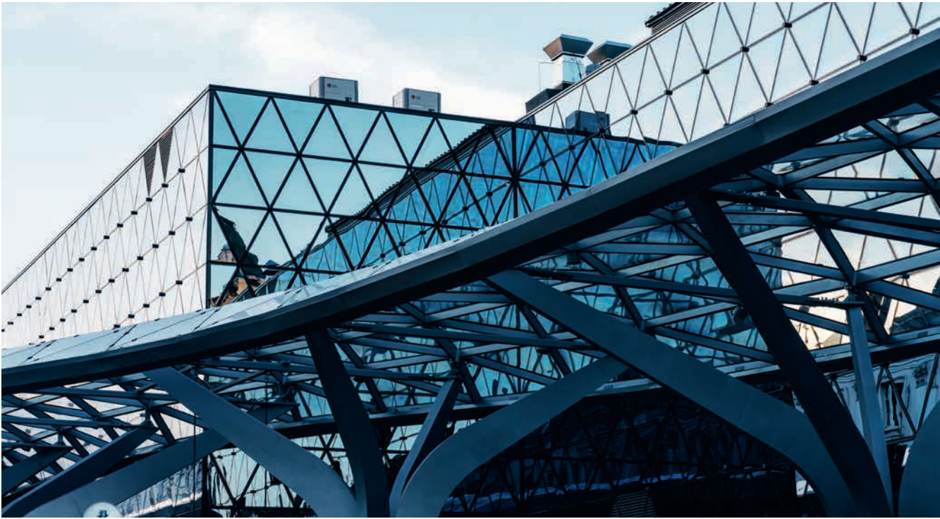
Высота прозрачных навесов достигает 15 м. Они не перегружают пространство и составляют полноценный ансамбль с основным зданием
